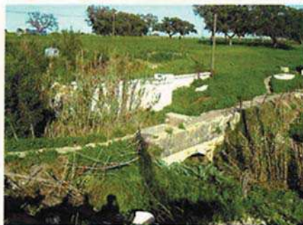
Acueductos de aguas de Tempul y Los Hurones.
