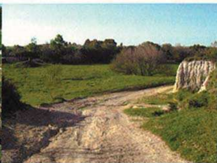
Cañada Cuerpo de Hombre justo antes de unirse al camino del canal
